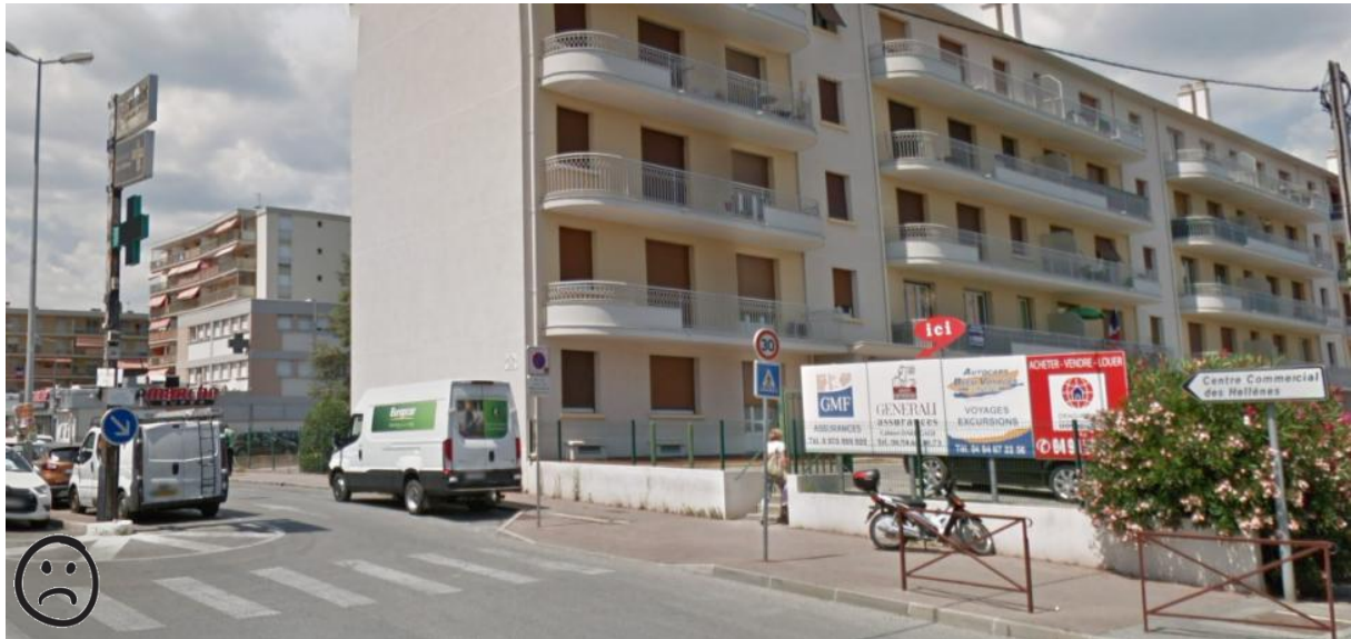
90. Zone commerciale des Hellènes – entrée principale
