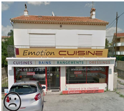
135. Avenue du général Charles de Gaulle
