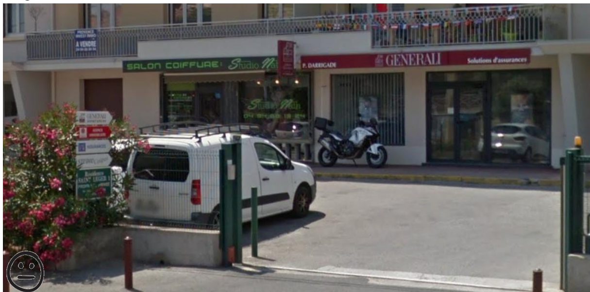
91. Zone commerciale des Hellènes - rez-de-chaussée commerciaux
