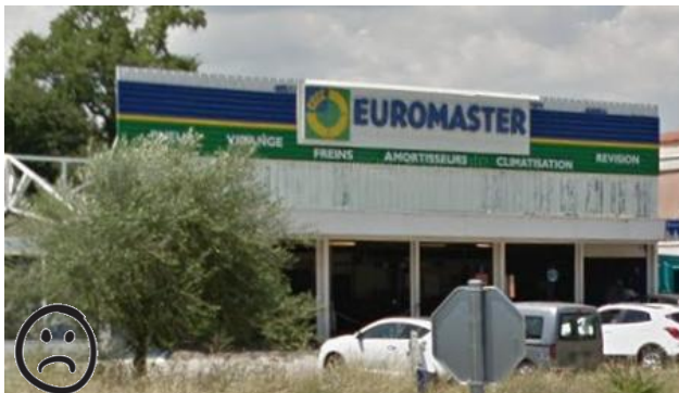
138. Avenue du Général Charles de Gaulle
