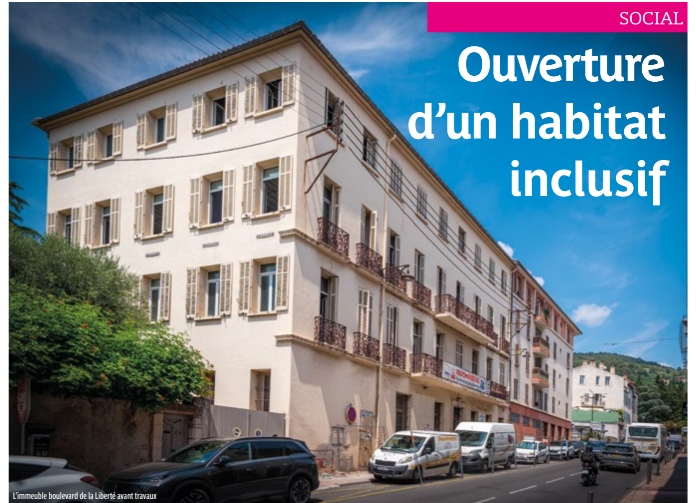
L'immeuble boulevard de la Liberté avant travaux
