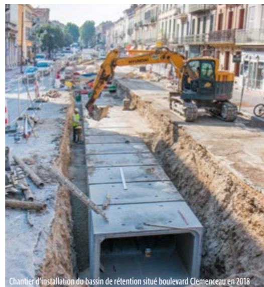
Chantier d'installation du bassin de rétention situé boulevard Clemenceau en 2018
