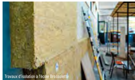
Travaux d'isolation à l'école Brossolette
