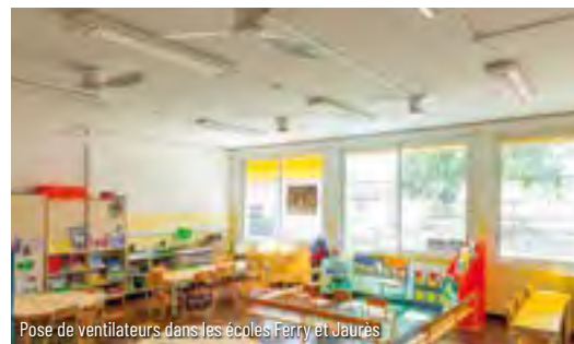
Pose de ventilateurs dans les écoles Ferry et Jaurès
