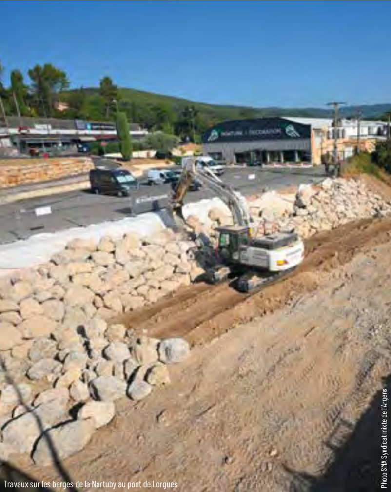
Travaux sur les berges de la Nartuby au pont de Lorgues
