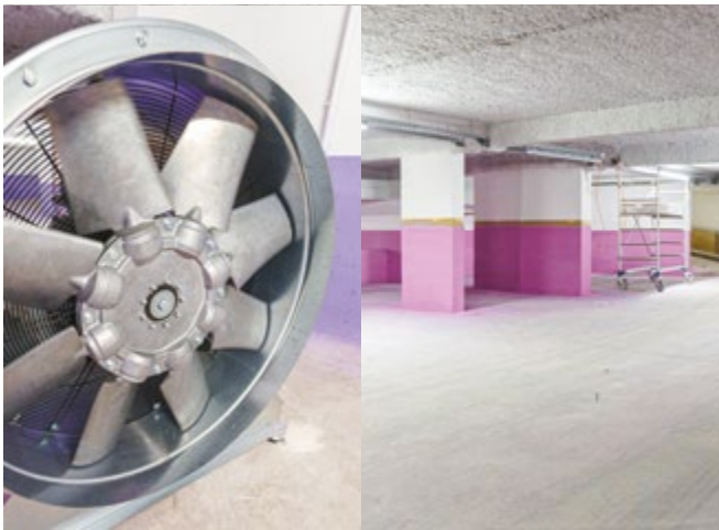
LES TRAVAUX RÉALISÉS AU PARKING DE L'ÎLOT DE L'HORLOGE
