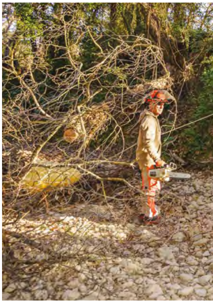
Travaux sur les berges de la Nartuby.
