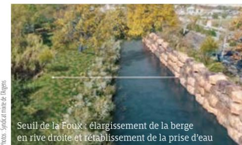
Seuil de la Foux : élargissement de la berge en rive droite et rétablissement de la prise d'eau
