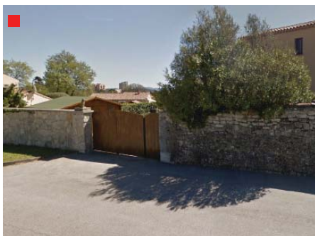
Les reprises de murs en pierres existants doivent permettre de valoriser le patrimoine existant sans tomber dans le pastiche > préférer un mur enduit à arase arrondie plutôt qu'un parement en pierres sciées et une couverture en béton...
