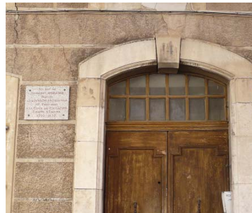
Exemple de marquage au fer de l'enduit figurant de fausses pierres
