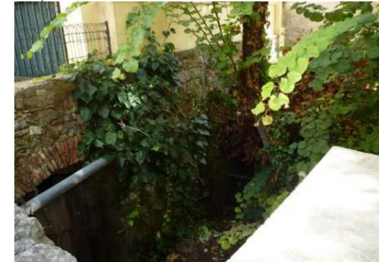
Canal souterrain creusé dans le calcaire tendre, briques fabriquées à partir d'argiles locales (?) formant voûte, expressions de la géologie dans les paysages urbains.
