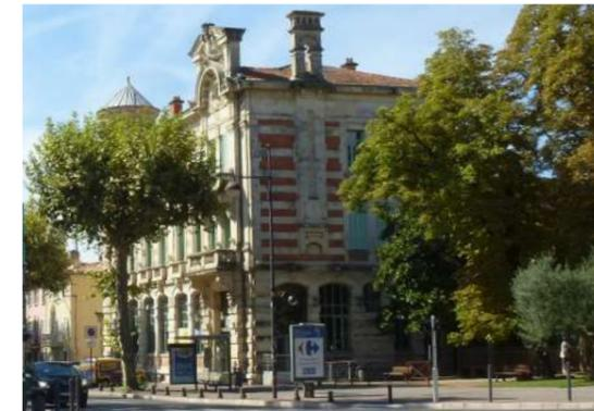
Les briques sont plutôt utilisées en remplissage / tout venant et apparaissent discrètement à la faveur de dégradations des enduits de façades. La façade de la poste fait exception.
