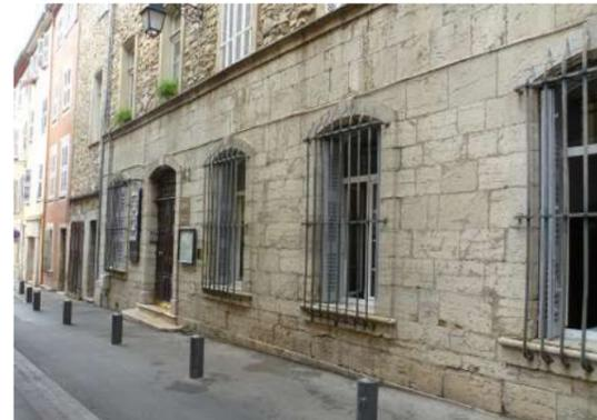
Les calcaires durs sont préférentiellement utilisés taillés pour les soubassements, chaînages d'angle, linteaux, seuils, appuis...
