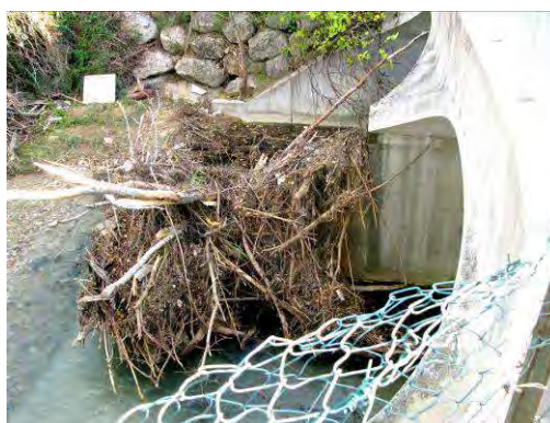
Photos 108 : Accès Carrefour Trans en Provence – 2 arches circulaires accumulant les embâcles
