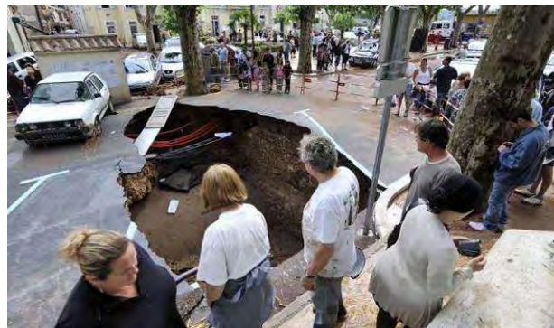
Photos 45 : Le Réal dans le centre ville des Arcs – dégâts au niveau du passage souterrain – Vue post crue
