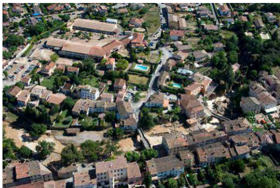
Photos 111 : Trans en Provence centre – Post Crue
