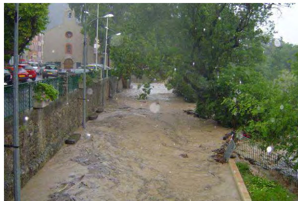
Photos 112 : Trans en Provence centre – Post Crue
