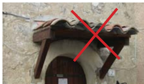
Auvent charpente bois interdit
