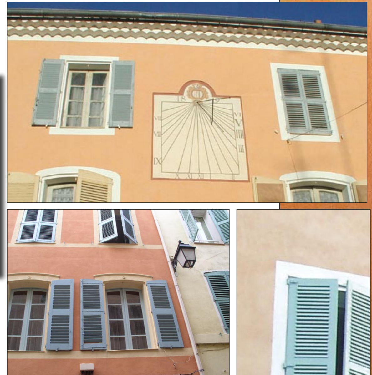
Place Roger Fréani et Rue de l'Observance : façades de teintes "pastels" avec des modénatures néo-classique (à droite) et un cadran solaire à la fresque (ci dessus)
