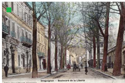
Un espace dédié à la voirie resserré, de larges trottoirs (avenue de la République avant l'ère de la voiture).
