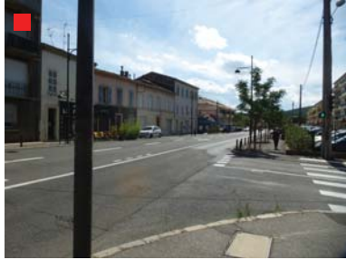
Un des principaux axes d'entrée de ville (avenue du Maréchal Juin): un aspect très routier qui appelle une réflexion sur l'échelle des plantations et le niveau de végétalisation de l'ensemble.
